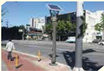
현장에 설치된 태양에너지 블록 유량시스템
